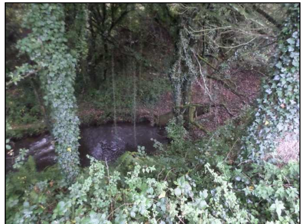
Exutoire du dalot dans le Tohon aval
