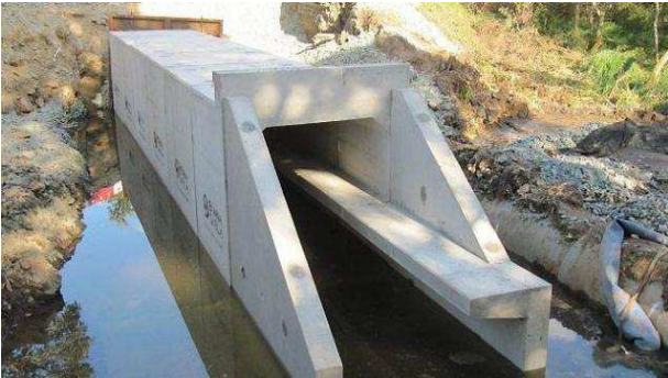
(exemple de réalisation de passage à loutres)
