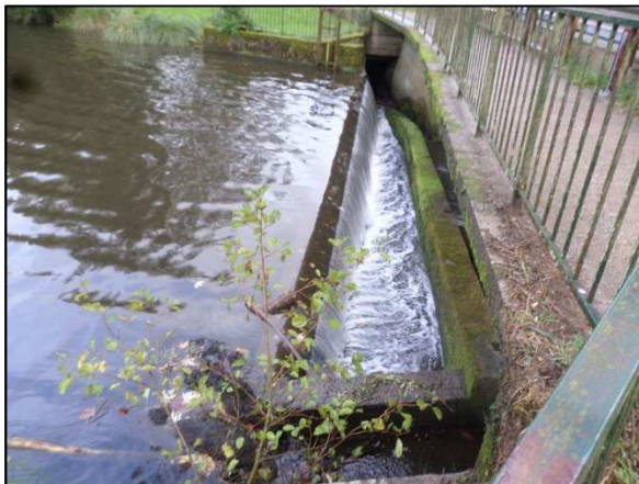
Les ouvrages en aval du plan d'eau
